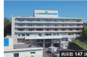
イムス横浜狩場脳神経外科病院 〒240-0025 神奈川県横浜市保土ヶ谷区狩場町218-9 TEL:045-721-3131 https://www.karibonouge.com/
