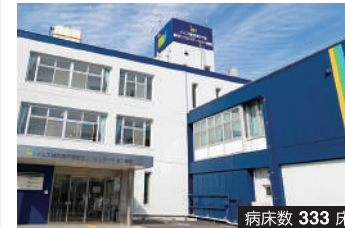
イムス横浜東戸塚総合リハビリテーション病院 機臨 〒244-0805 神奈川県横浜市戸塚区川上町690-2 TEL:045-822-4151 https://www.ims.gr.jp/yokohama_higashitotsuka_reha/
